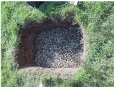
Rivestimento del fondo della buca con sabbia o ghiaia.
