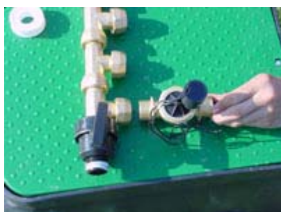
Montaggio elettrovalvola.
