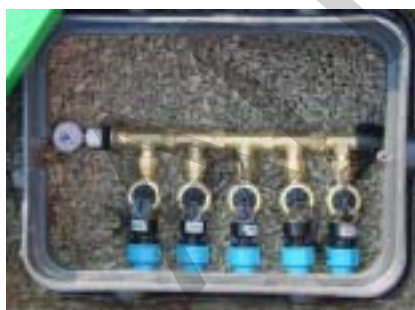
Collettore completo inserito nel pozzetto.
