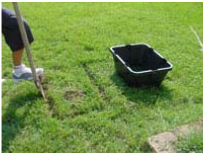
Tracciatura della buca da scavare
