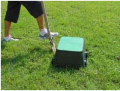
Posizionamento del pozzetto
