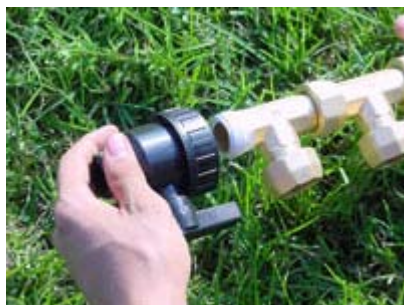
Montaggio della valvola manuale.
